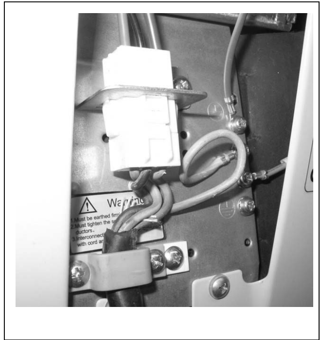
Elektrischer Anschluss am Außenteil
