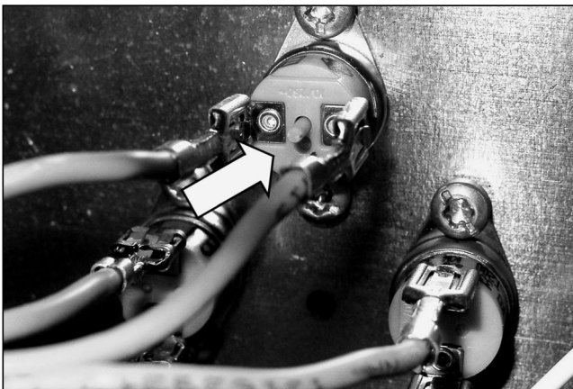
21. Rücksetzen des Temperaturbegrenzers (Störfall) Nur vom Fachmann auszuführen! – Speicherheizgerät spannungsfrei schalten. – Gerät ausreichend abkühlen lassen. – Rechte Seitenwand abnehmen. – Rücksetzknopf z. B. mit flacher Schraubendreherklinge betätigen.
