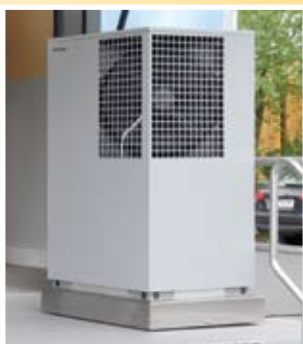
Luft/Wasser-Wärmepumpe zur Außenaufstellung
